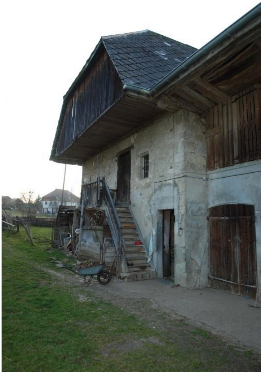
Vue d'ensemble de côté de l'élévation des communs.
