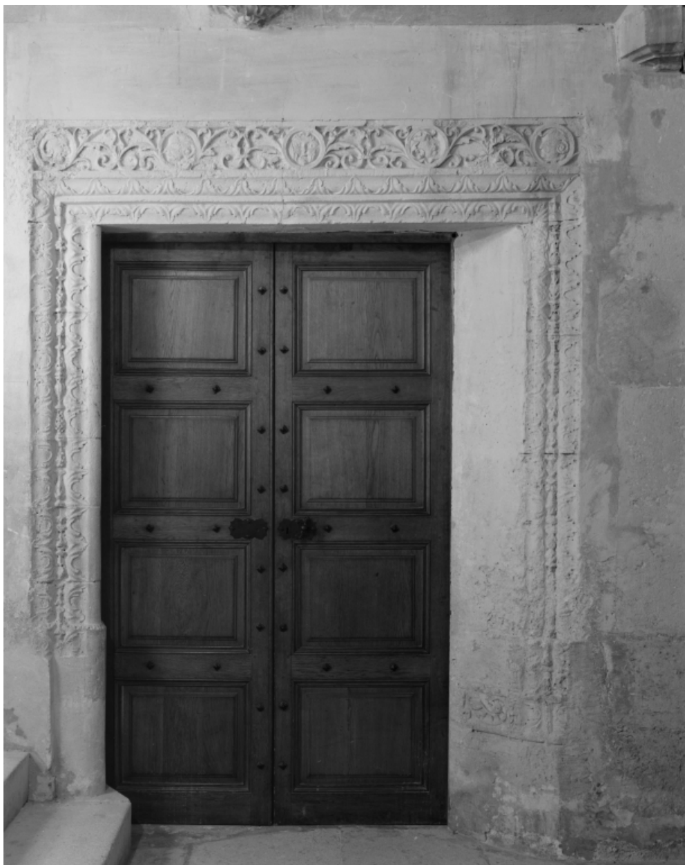
Escalier droit. Chambranle de porte. Décor antiquisant.
