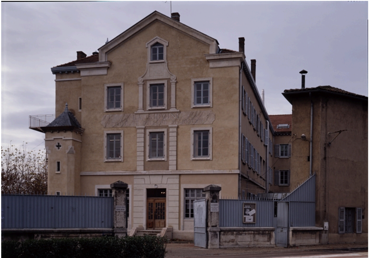
Élévation antérieure gauche après restauration : décor feint.
