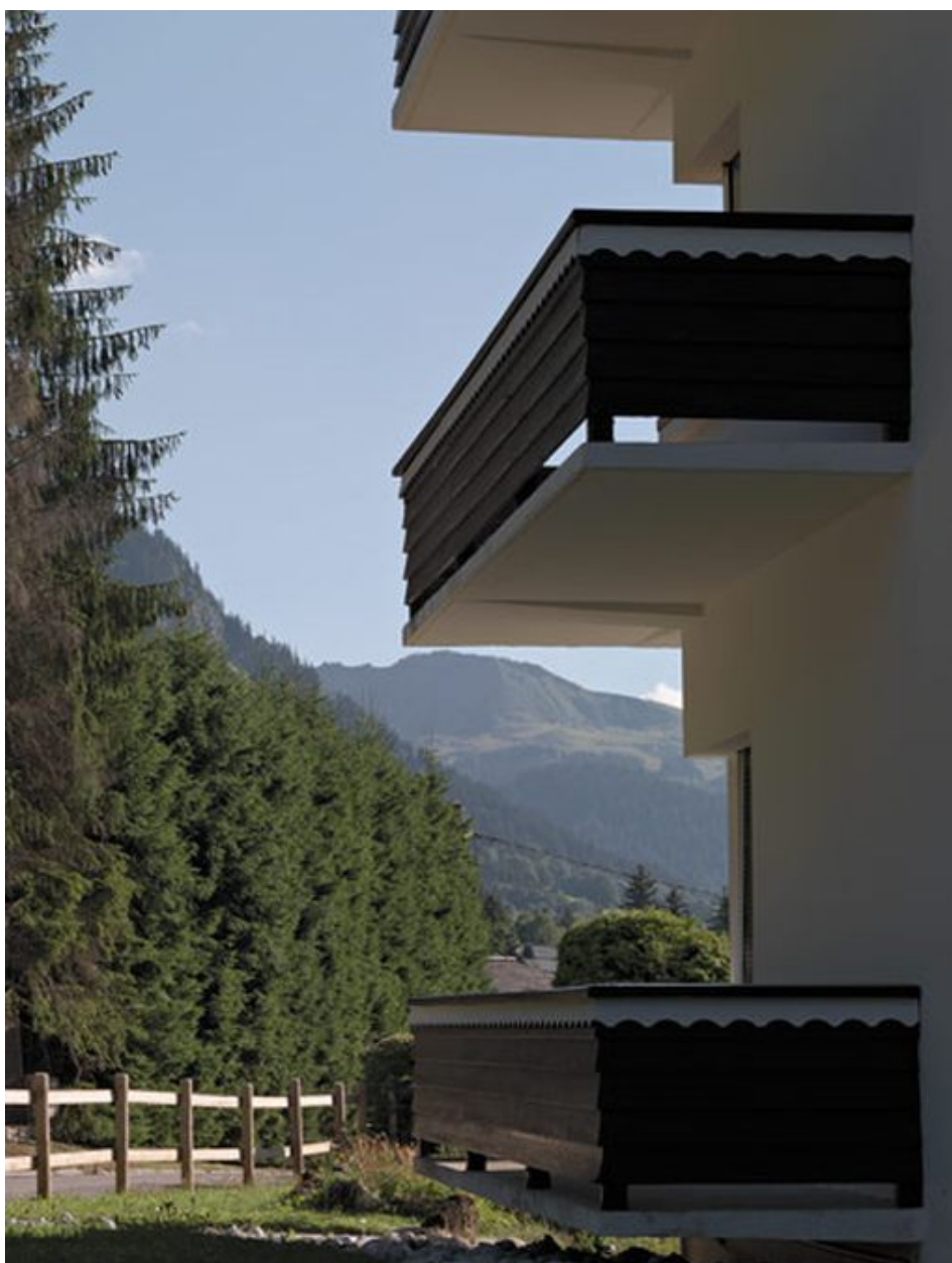
Détail des balcons de l'angle sud-est
