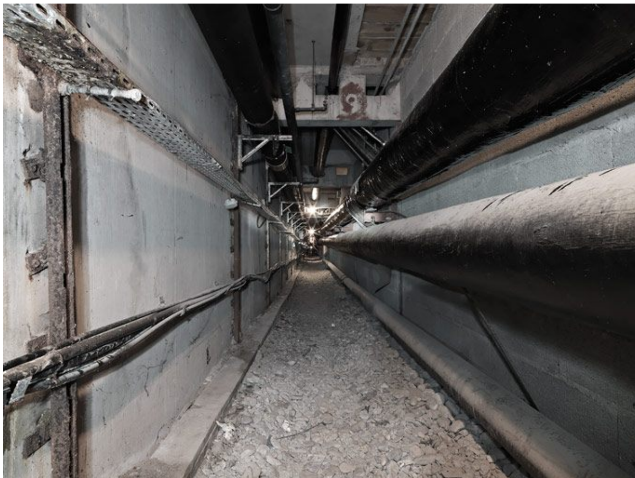
La galerie est-ouest sous la galerie marchande
