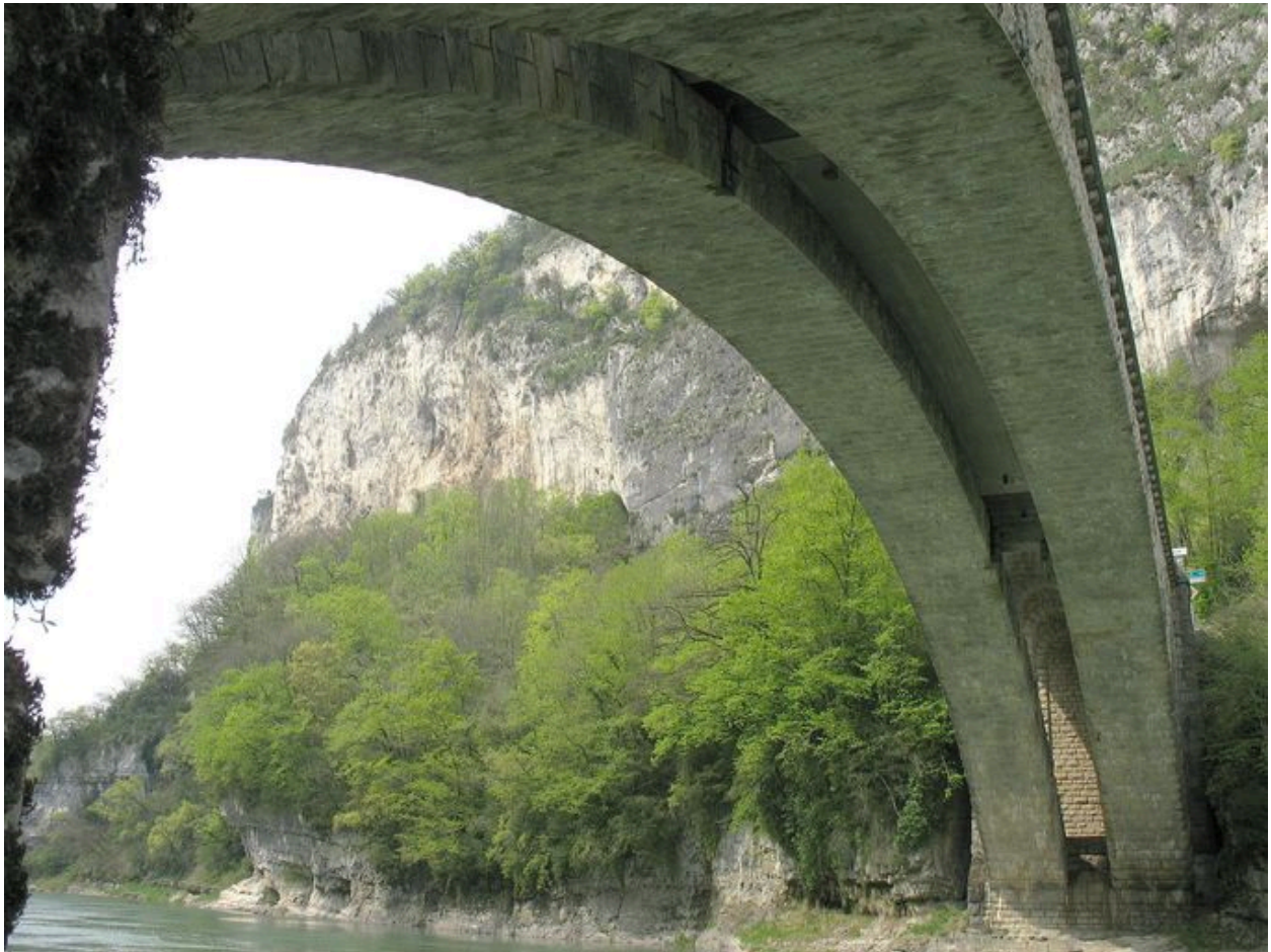
Vue du dessous de l'arche, depuis la rive gauche
