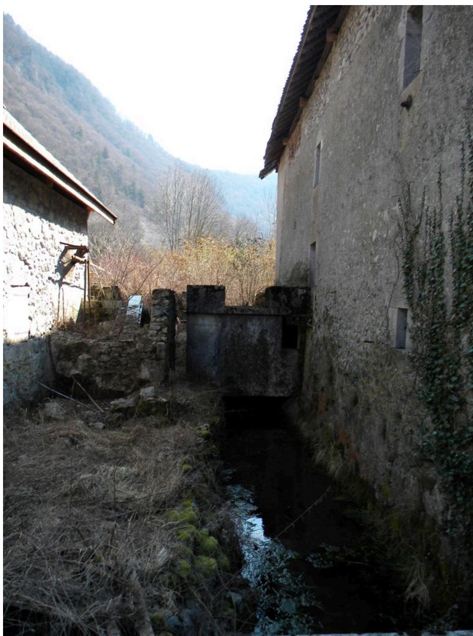
Façade du moulin sur le bief et vue sur le bloc de maçonnerie comprenant la turbine.
