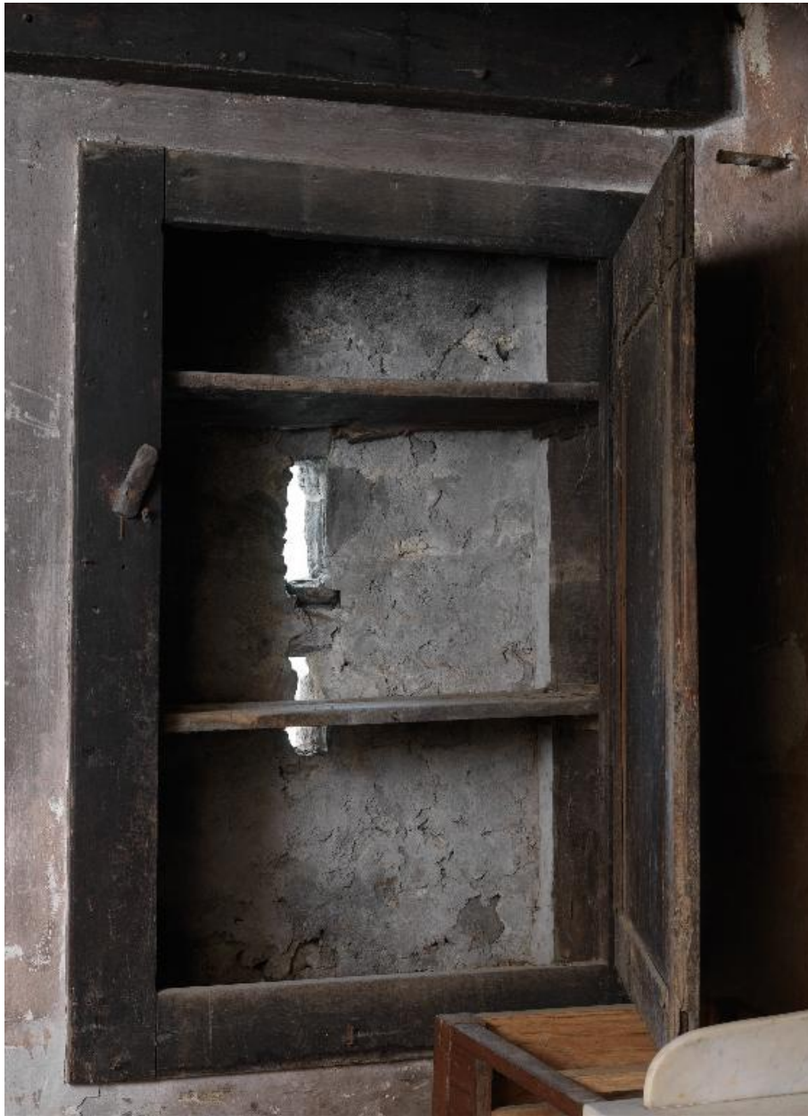
Vue intérieure du placard garde-manger avec jours aménagés dans le mur du fond de celui-ci, situé au nord.
