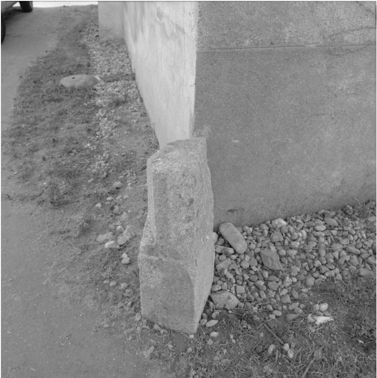
Détail d'une base de piédroit de cheminée en pierre.
