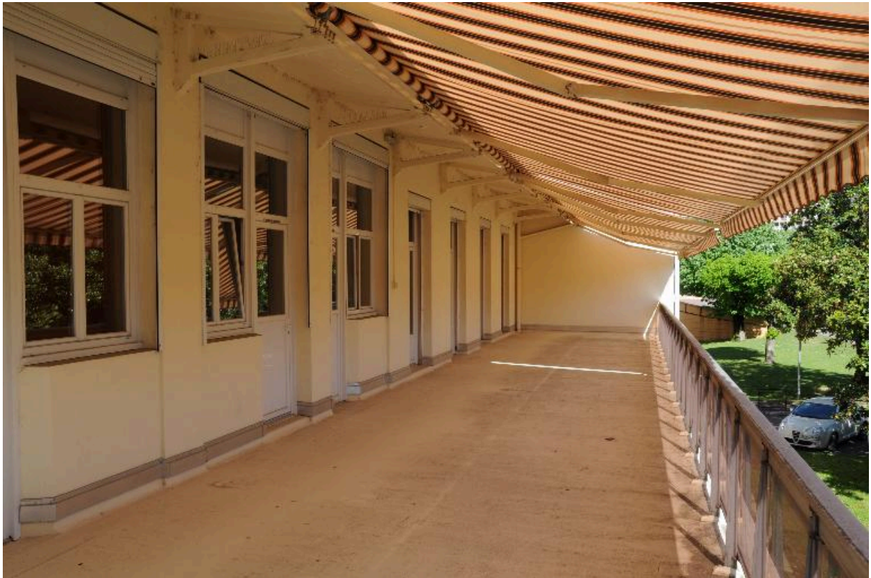
Terrasse du 1er étage, aile gauche
