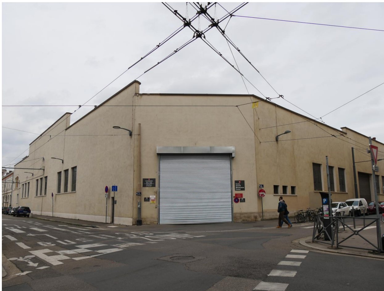
Vue d'angle avec la rue Dedieu
