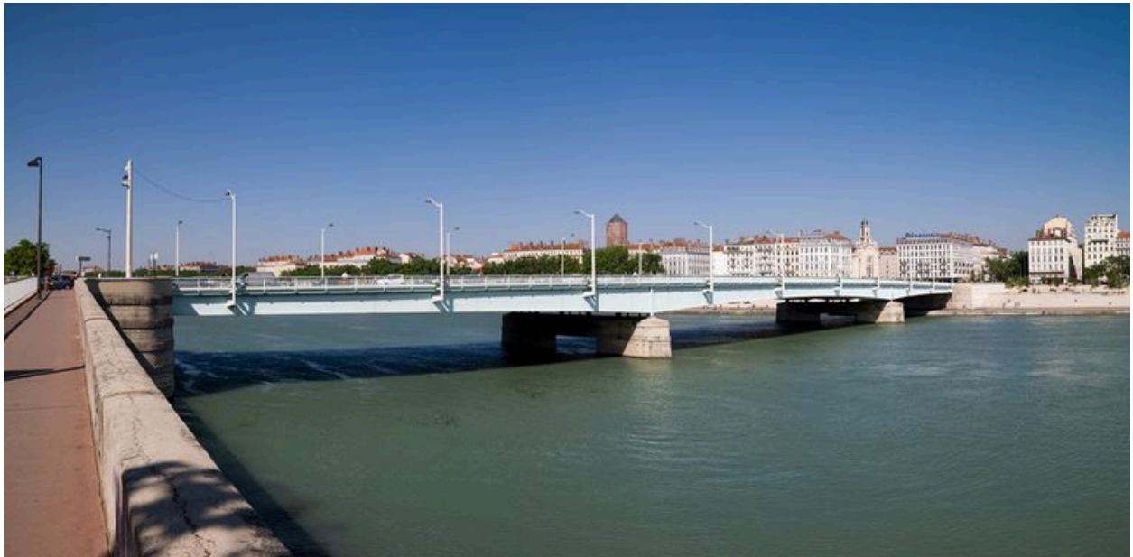
Vue générale, face aval (depuis la rive droite)
