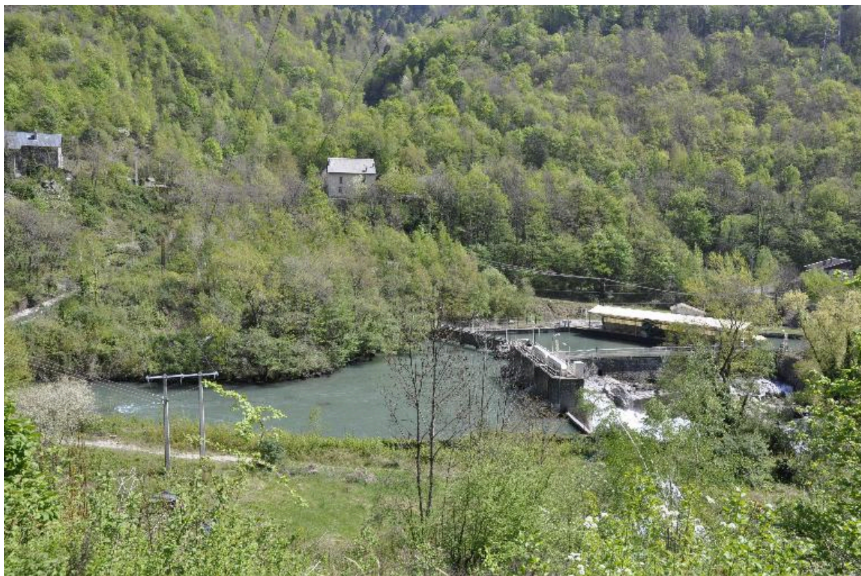
Vue d'ensemble du barrage
