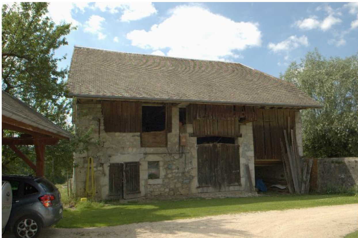
Vue d'ensemble de la grange -étable de face sur cour.
