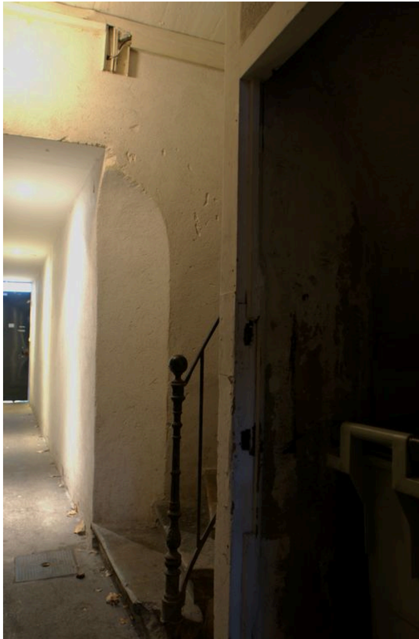
Le départ de l'escalier et l'angle abattu du mur du couloir
