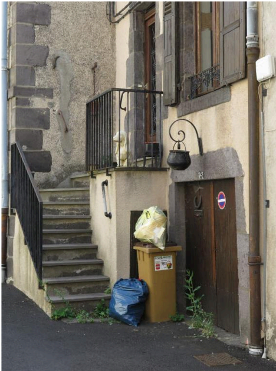
Escalier et entrée de la cave
