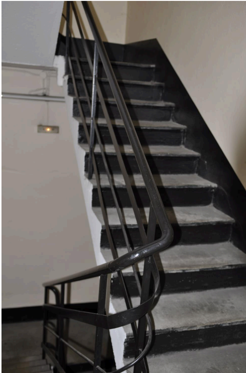
Escalier à volées droites vu de l'intérieur
