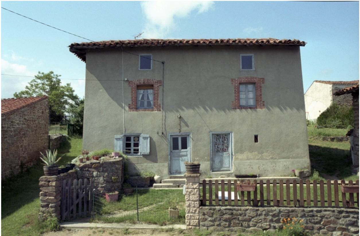
Vue de la façade antérieure du logis.
