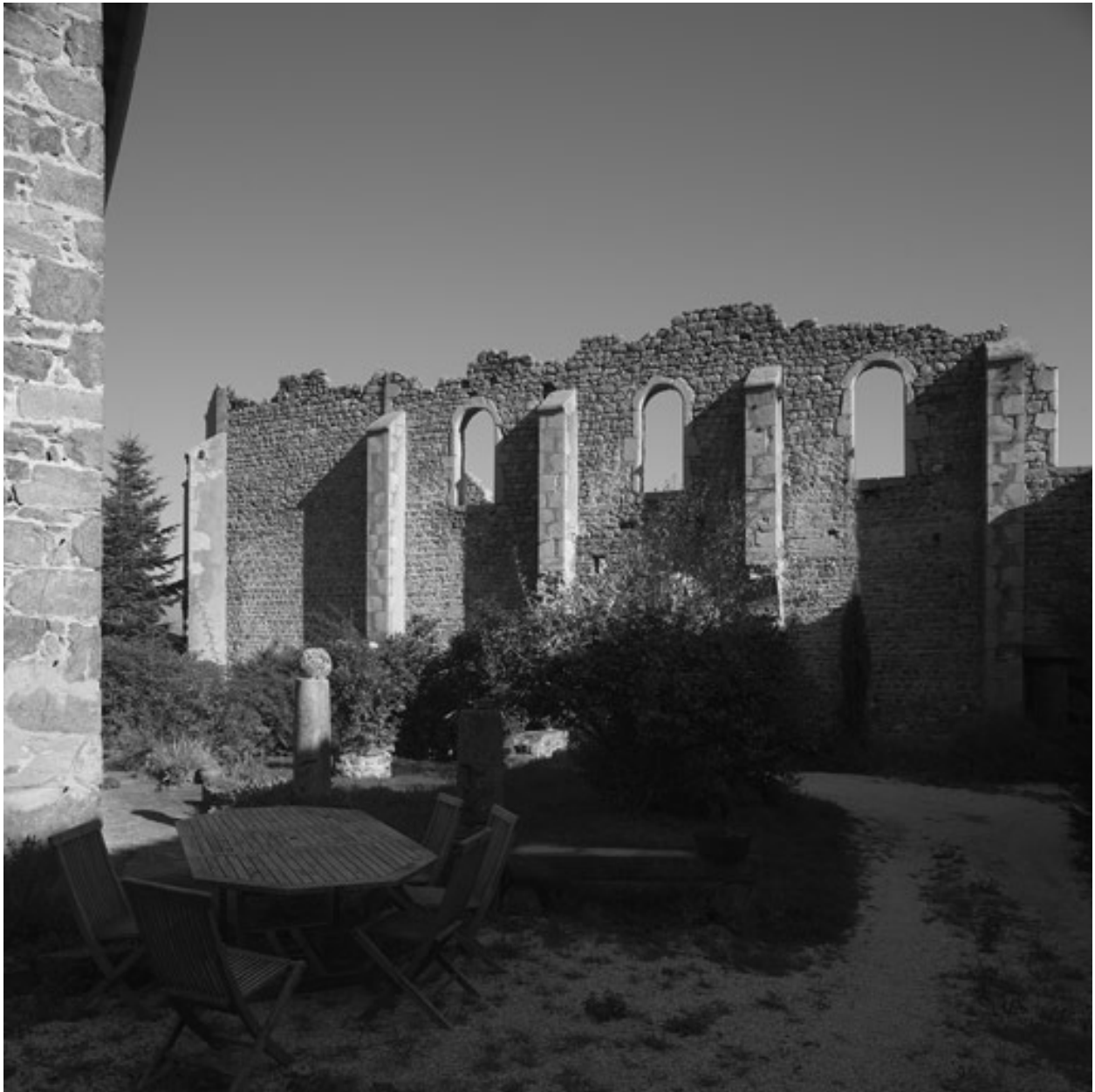
Vue d'ensemble du mur extérieure sud de la chapelle du petit séminaire de Verrières.
