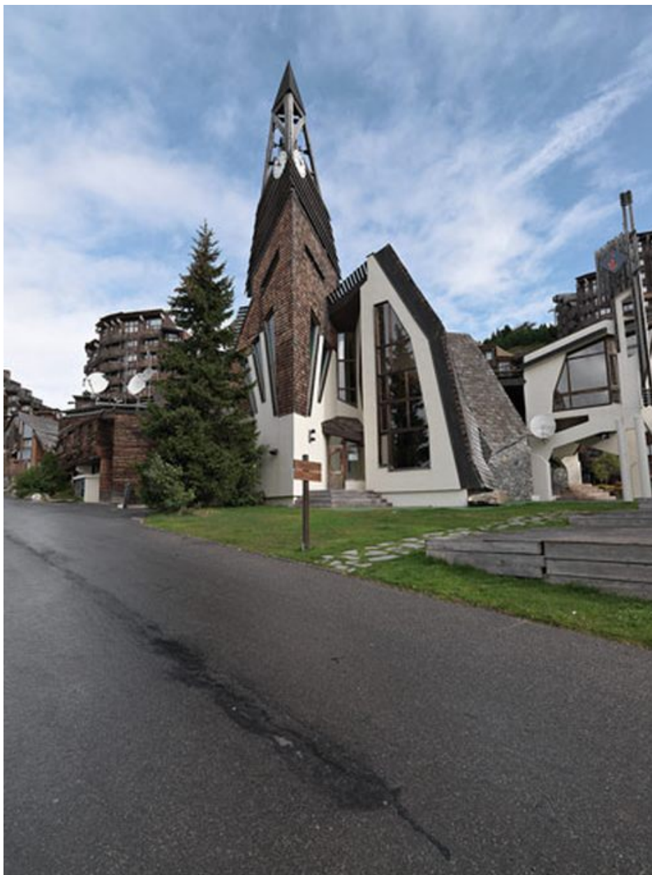
Vue d'ensemble du beffroi depuis le sud
