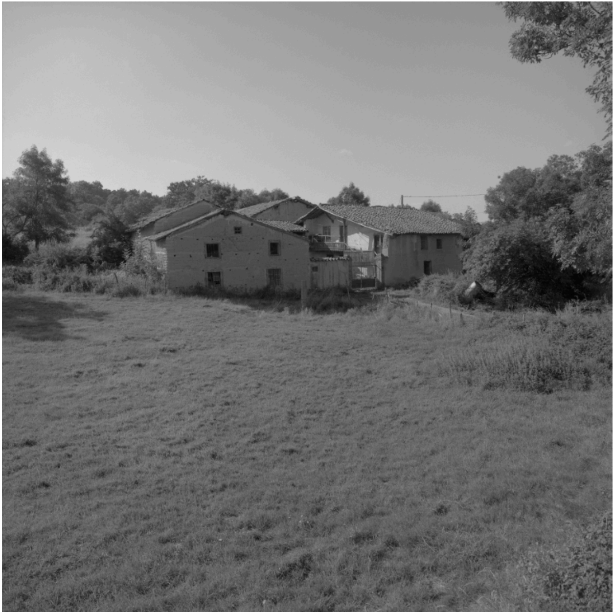
Saint-Sixte, Jay (1987 A3 906), type C2. Vue générale depuis la route.
