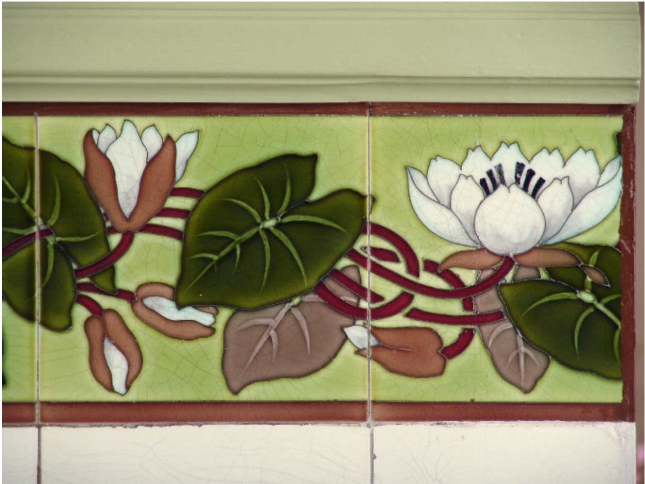
Appartement du 1er étage, céramique murale, détail de la frise
