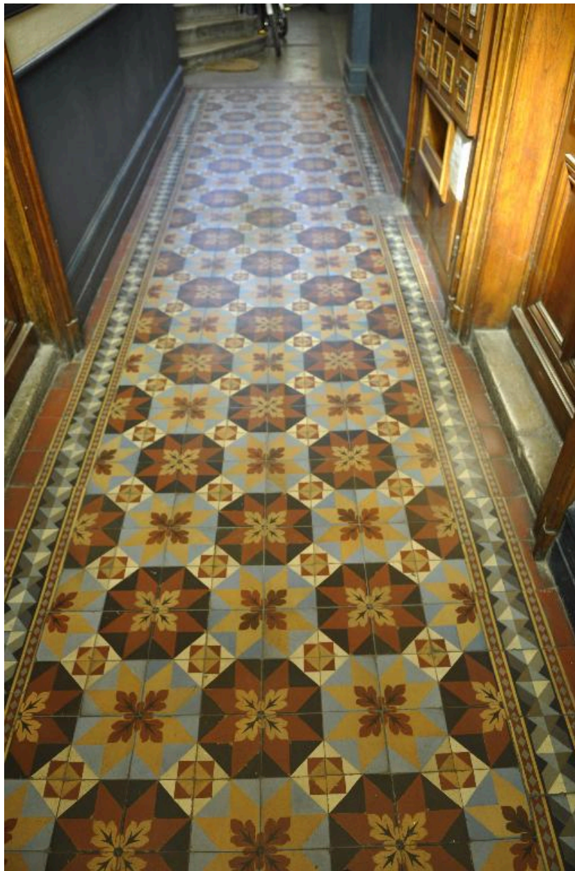
Vue intérieure : le pavement de l'allée
