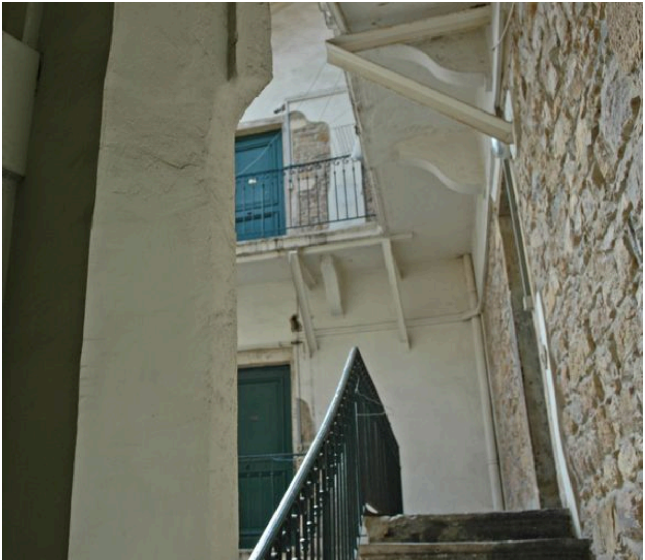
Les coursières depuis la porte de l'escalier principale
