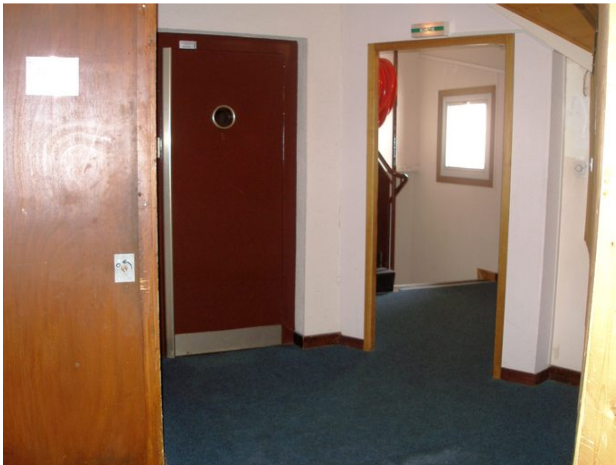
Arrivée d'un escalier sur un palier
