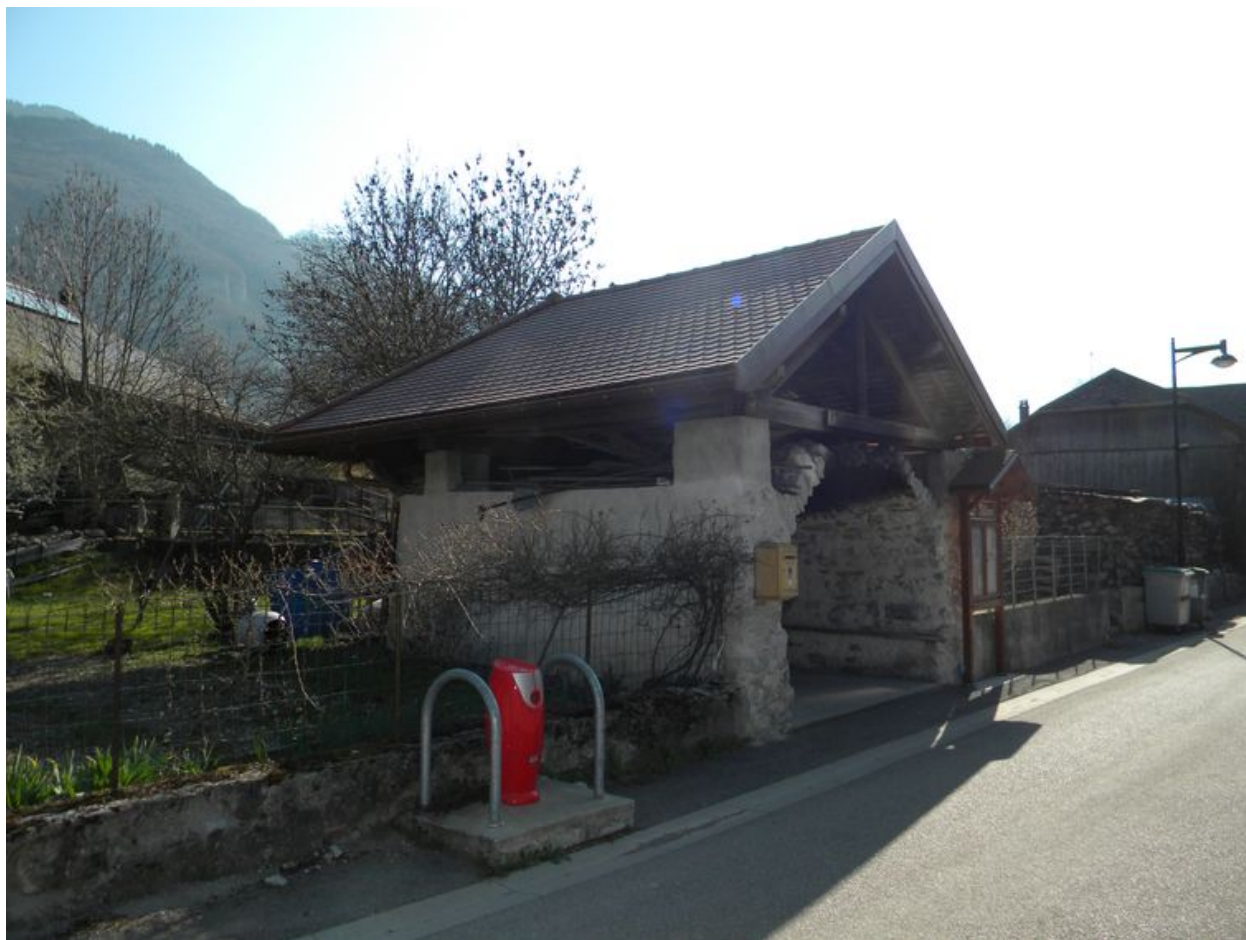
Vue de côté depuis la rue.
