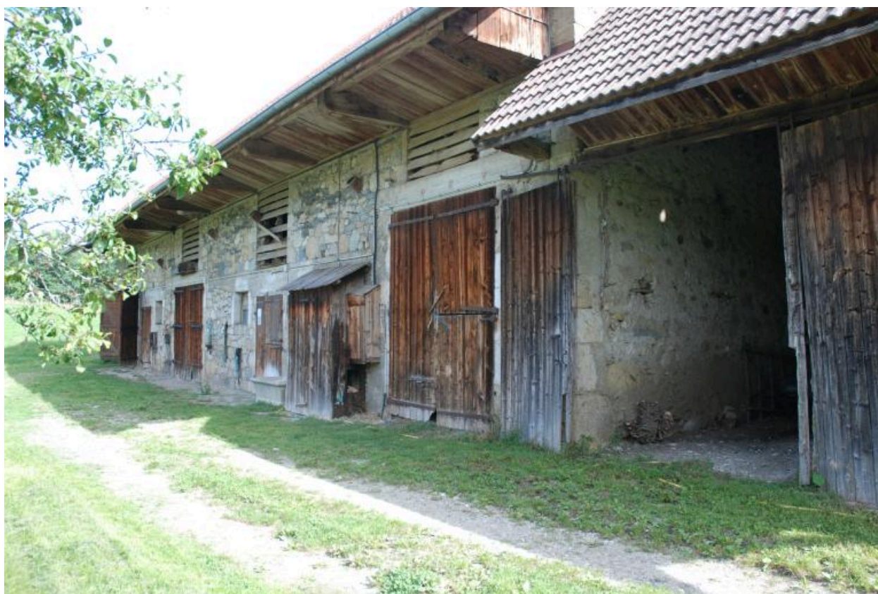
Vue d'ensemble de la façade avant des grange-étables.
