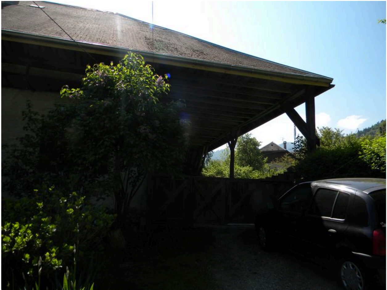
Détail du débord en appui sur des piliers d'angles.
