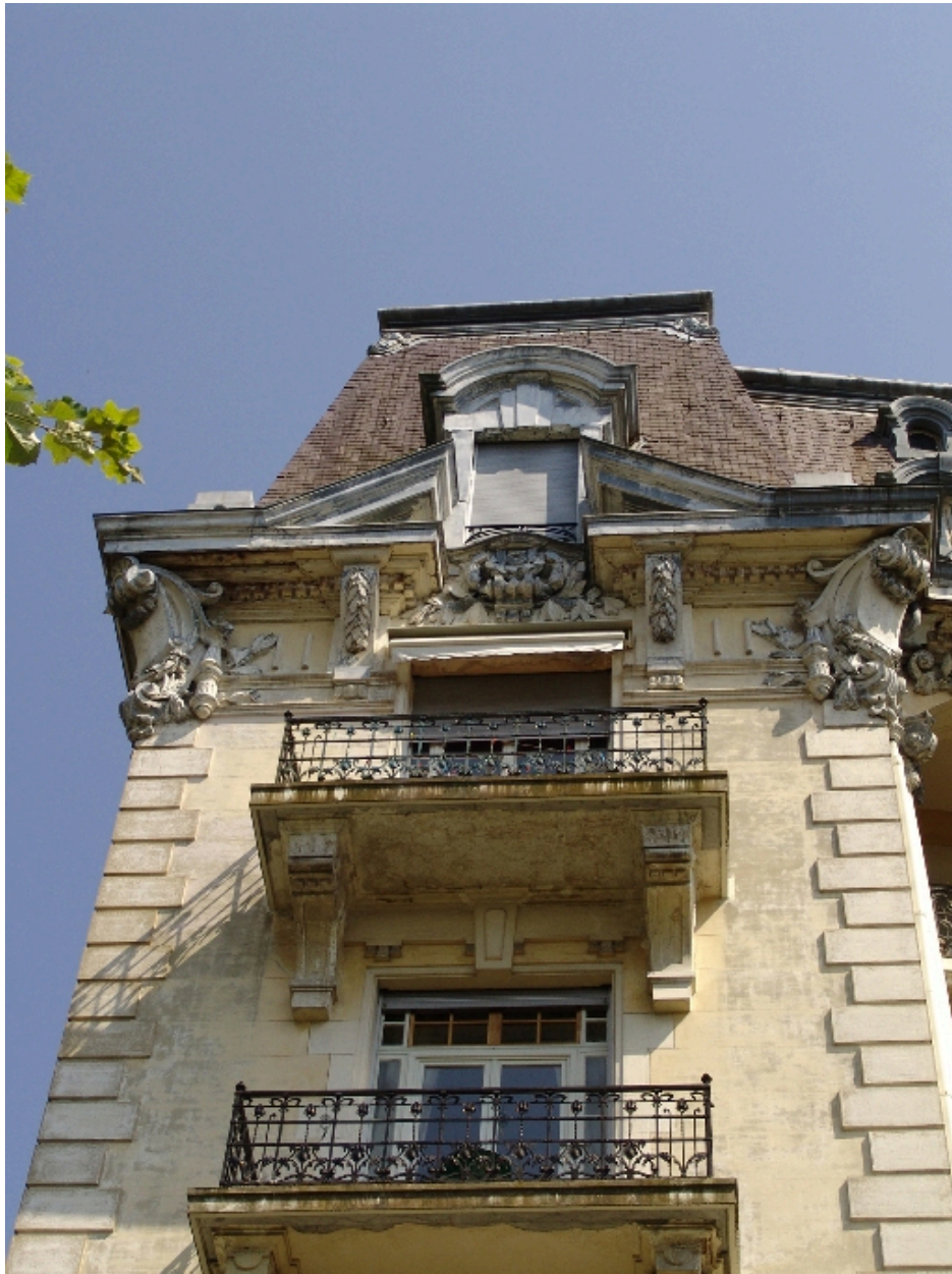
Façade sud-ouest : détail d'élévation
