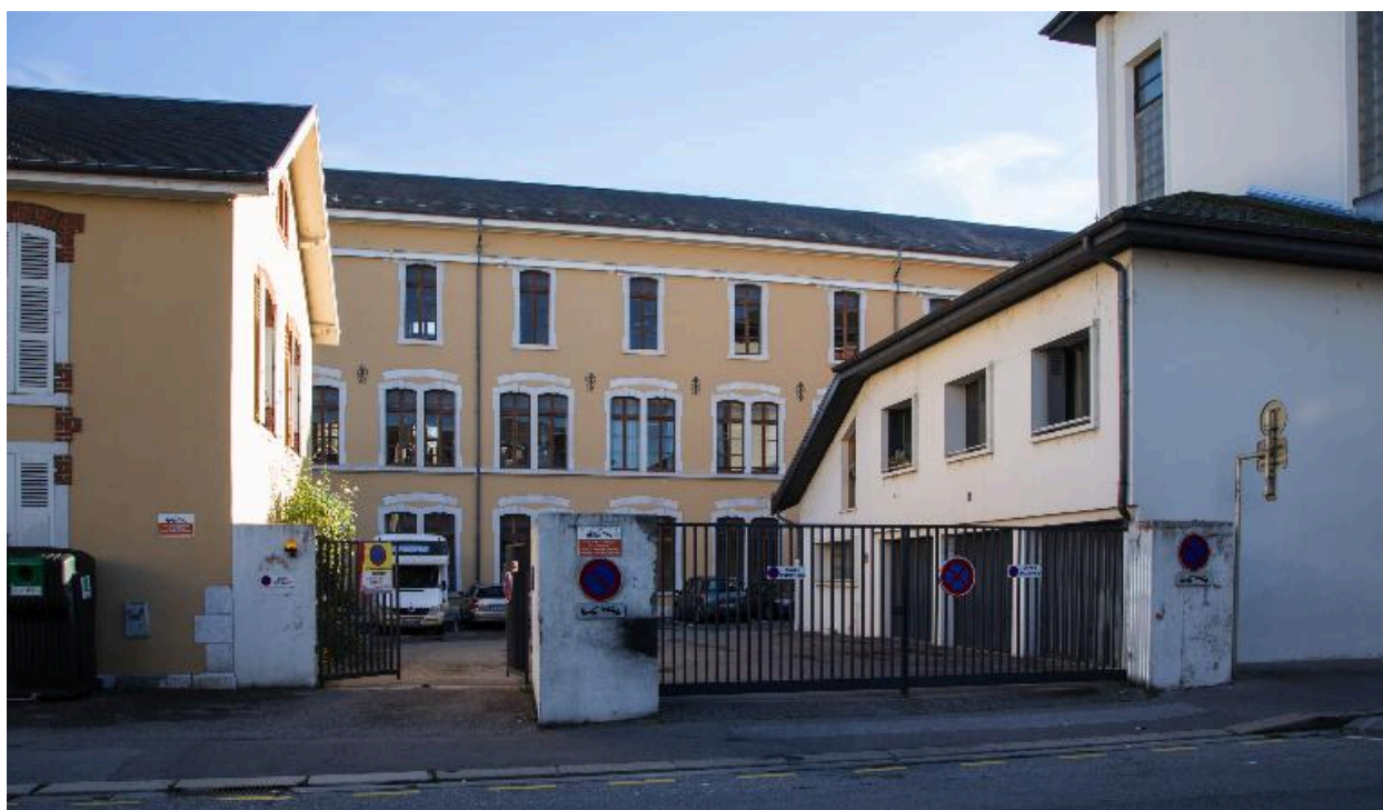
Entrée boulevard Nicolle : pavillons de jardin 19e et 20e.
