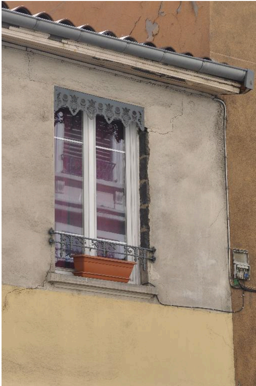
Vue rapprochée d'une fenêtre de l'étage
