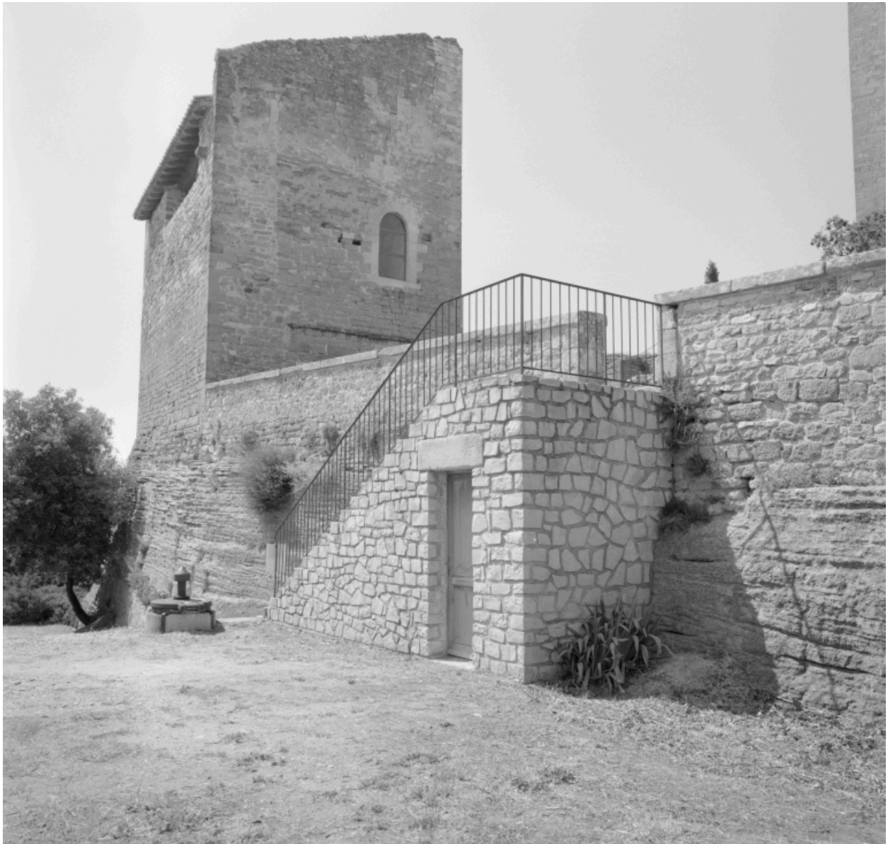
Elévations sud et est vues depuis la plate-forme.
