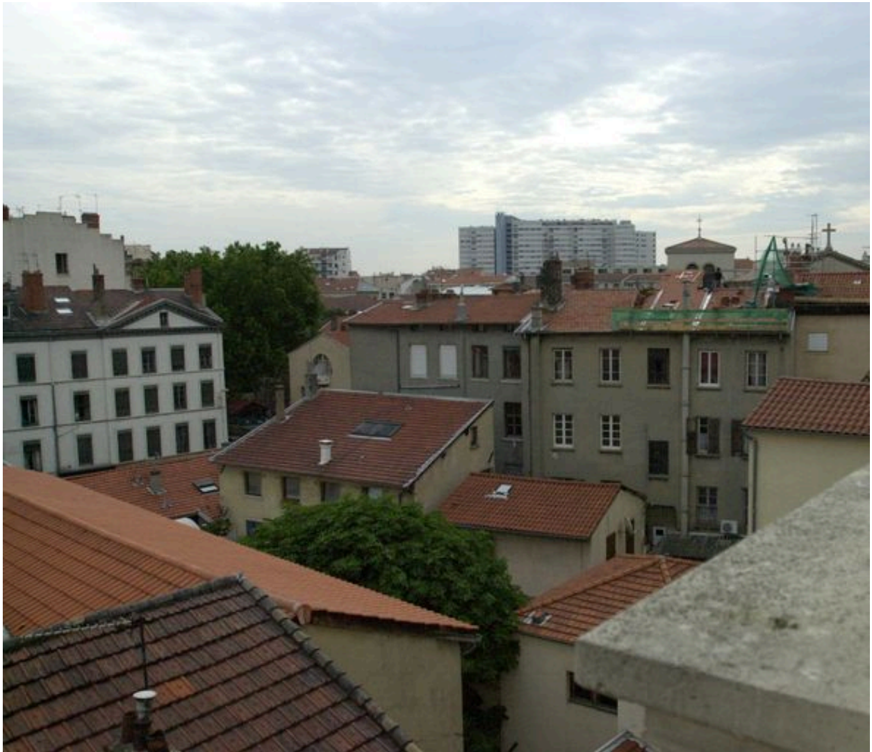
Vue de la toiture depuis le sud-ouest
