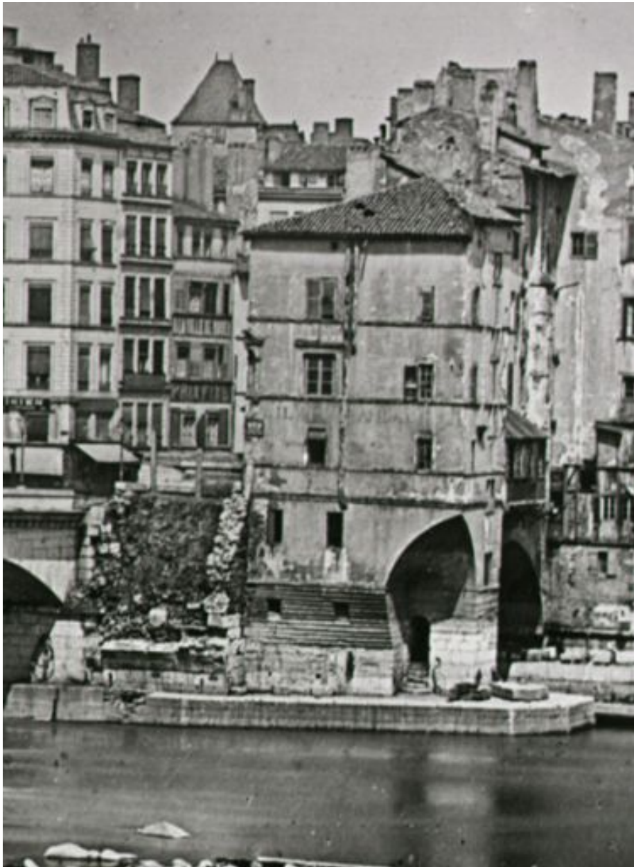
Démolition du Pont du Change, détail d'une fotogr., ca 1846-1847
