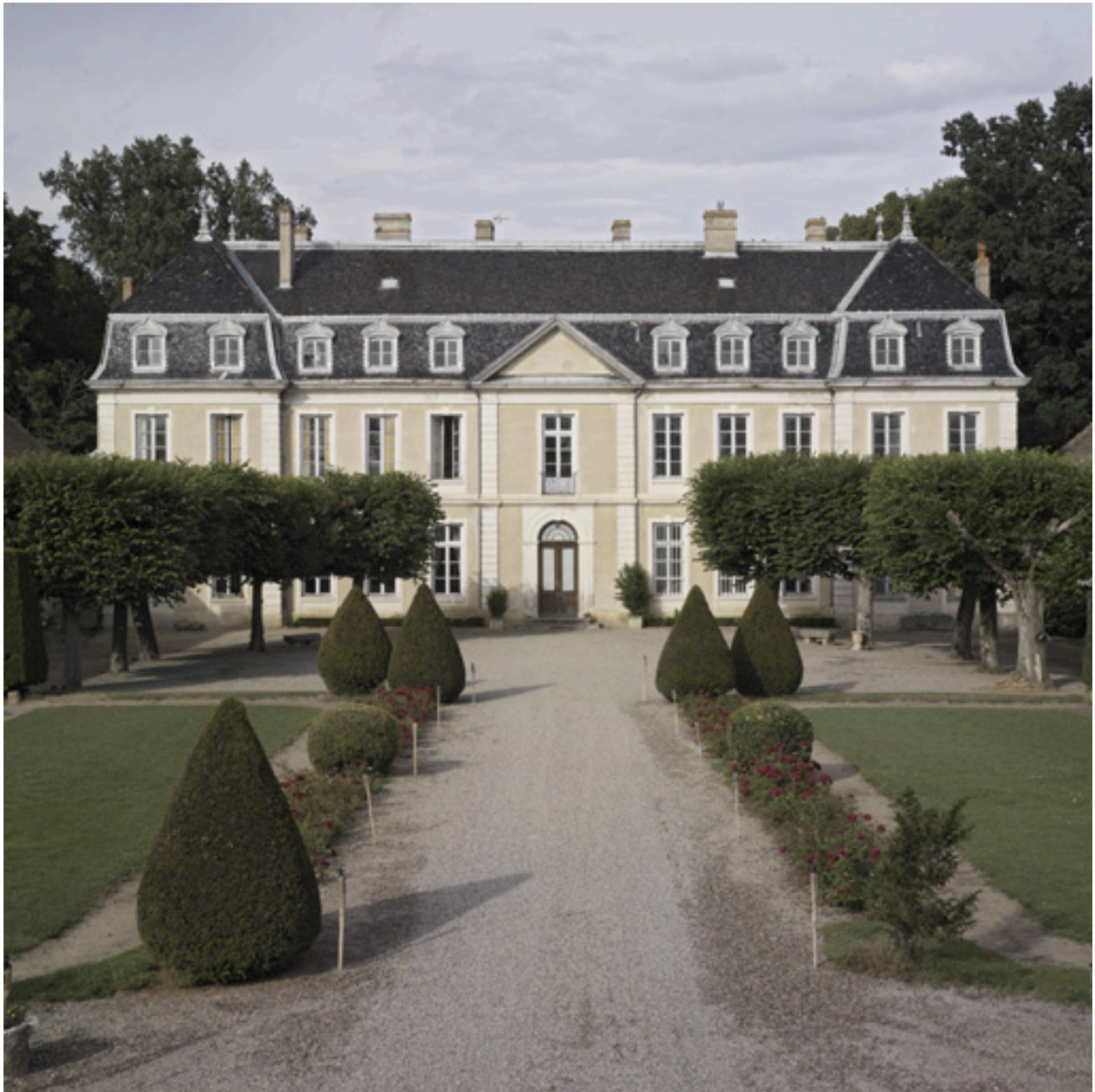
Vue de l'avant-cour et de la façade principale.
