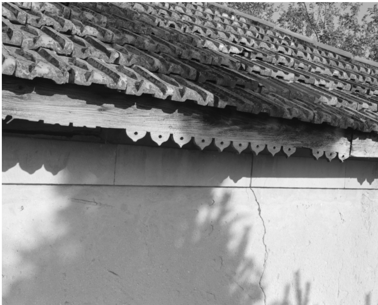
Détail du toit, bordé d'un lambrequin en bois découpé.
