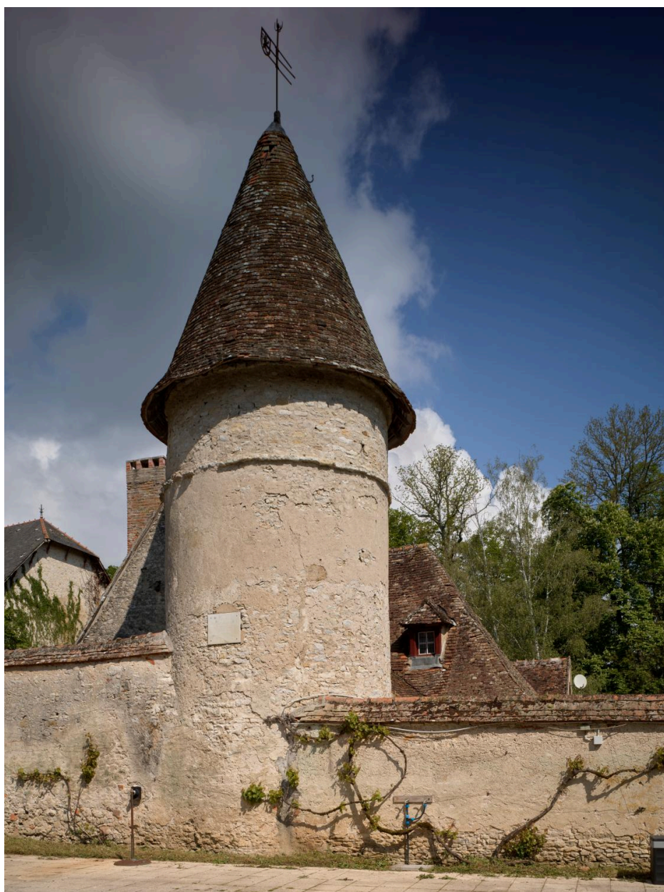
Vue générale de la tour au sud
