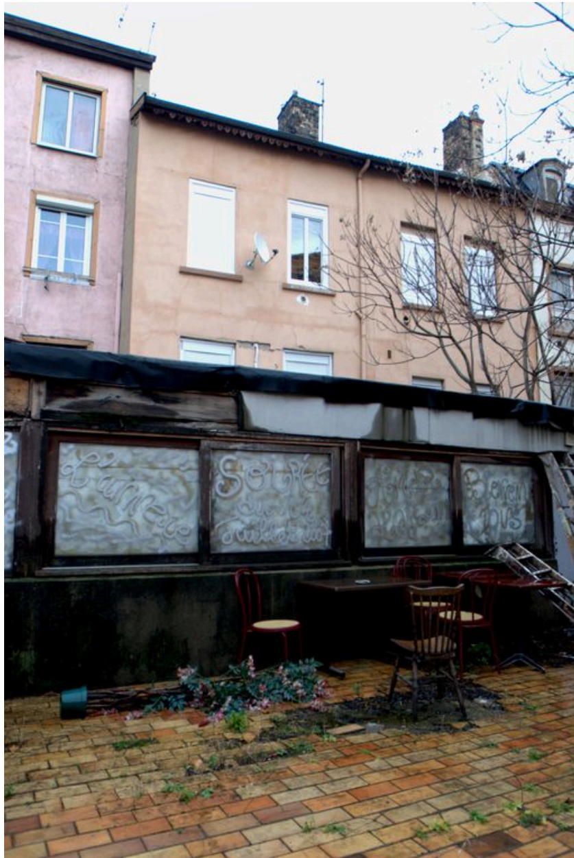
Elévation postérieure et annexe du restaurant construite dans la cour depuis le sud-ouest
