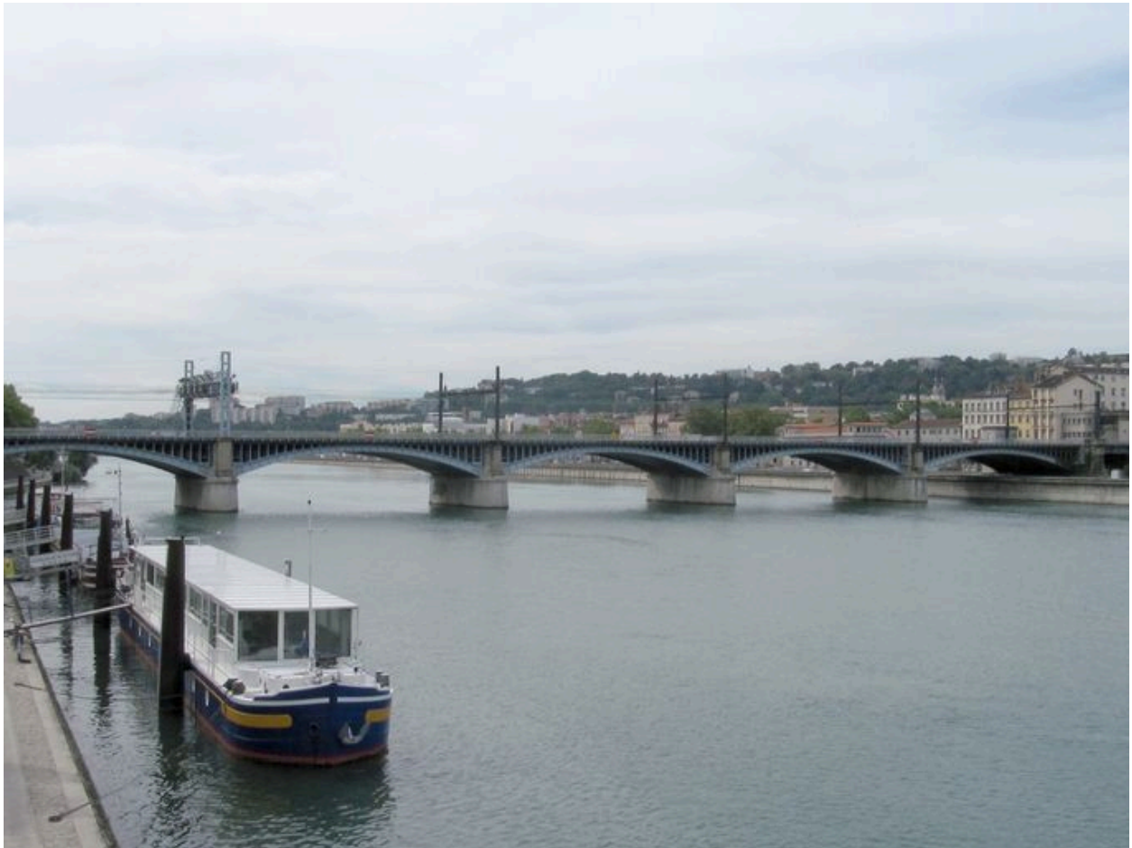
Vue générale, face amont (depuis le pont Galliéni)
