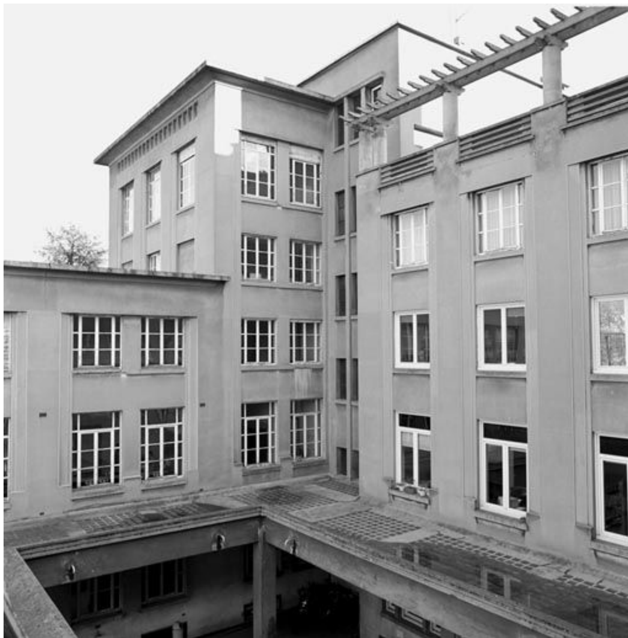
Façade au-dessus de l'atrium d'entrée
