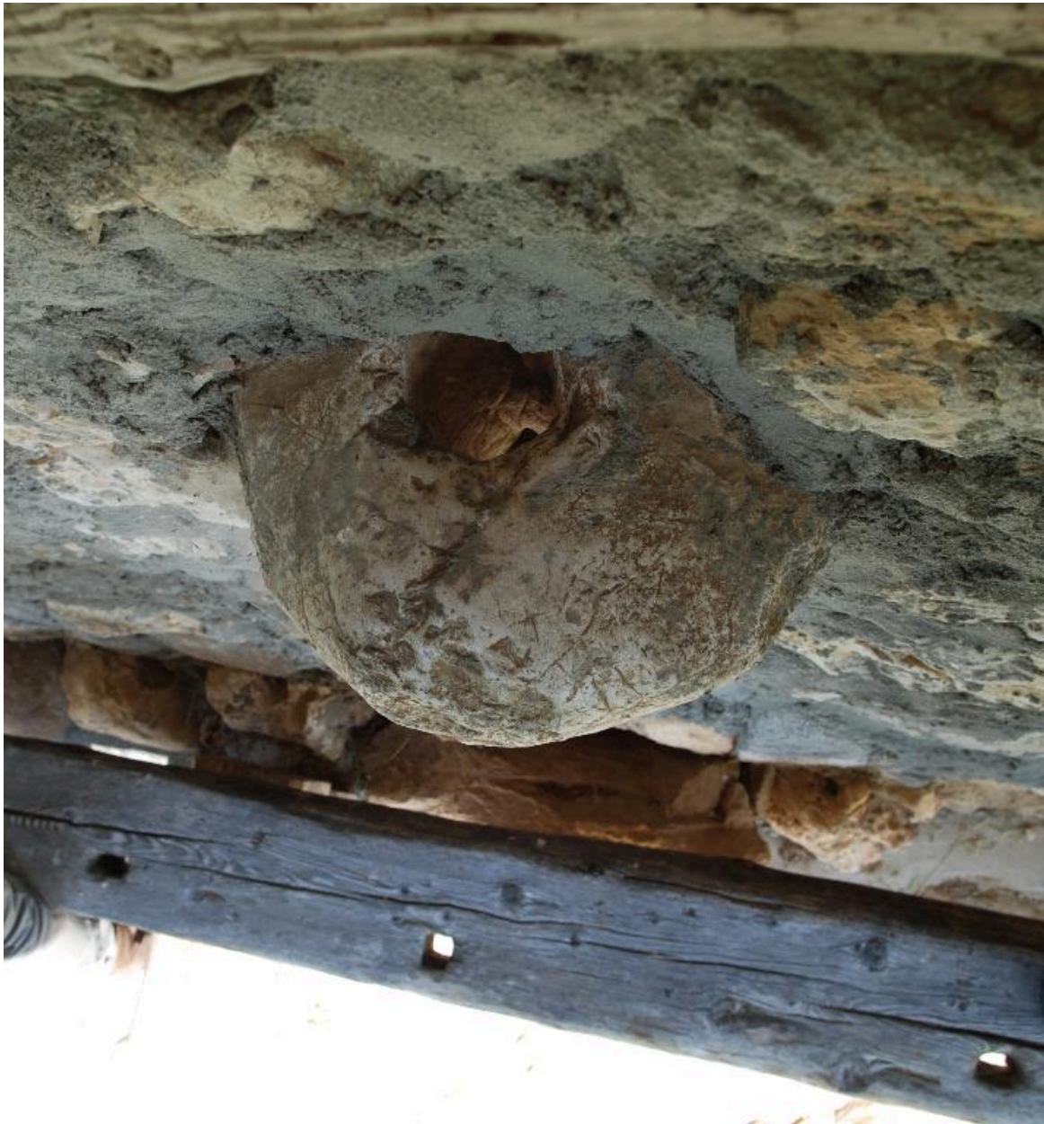
Détail de la façade : anneau en pierre (vu du dessus).
