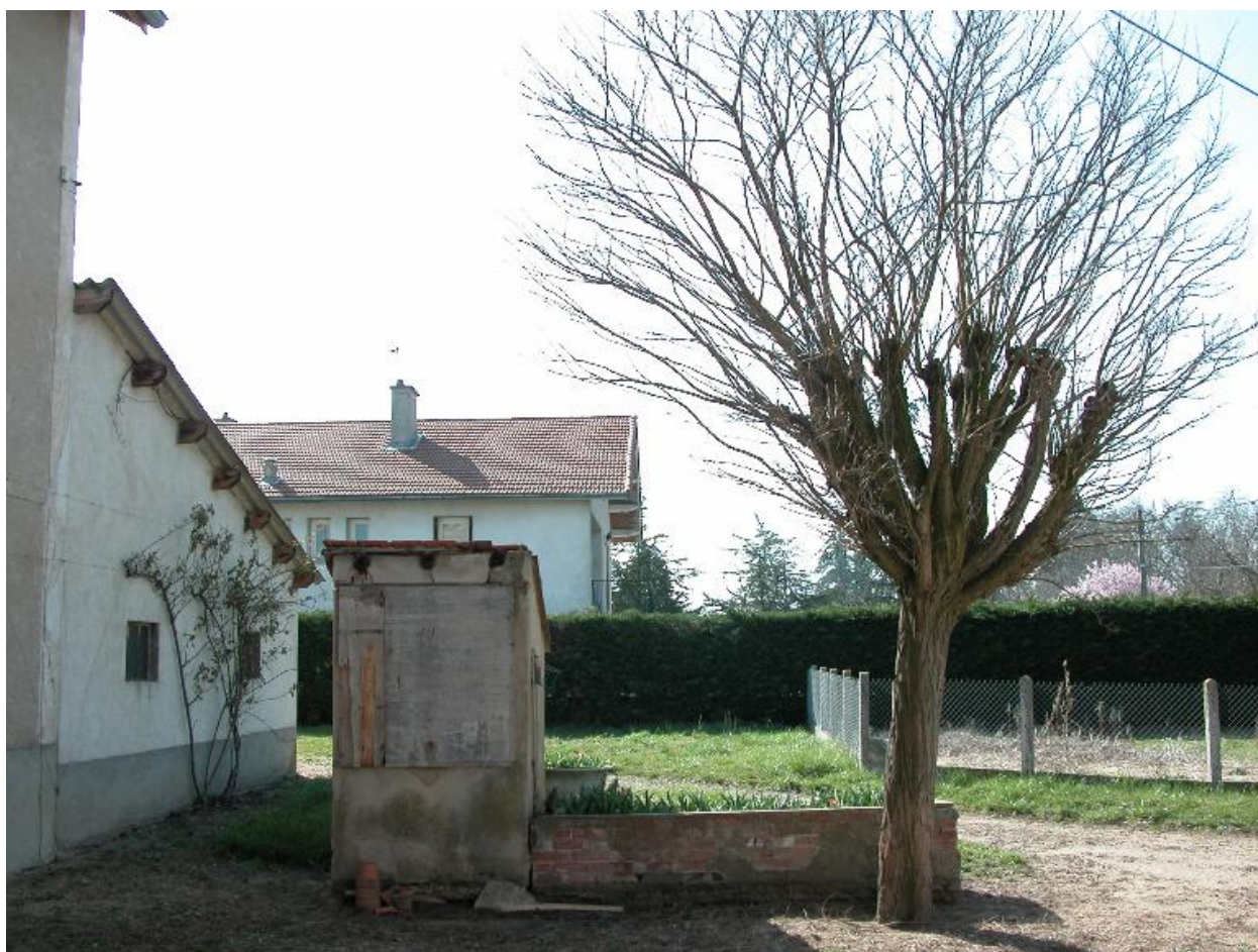
Vue d'ensemble du puits-abreuvoir
