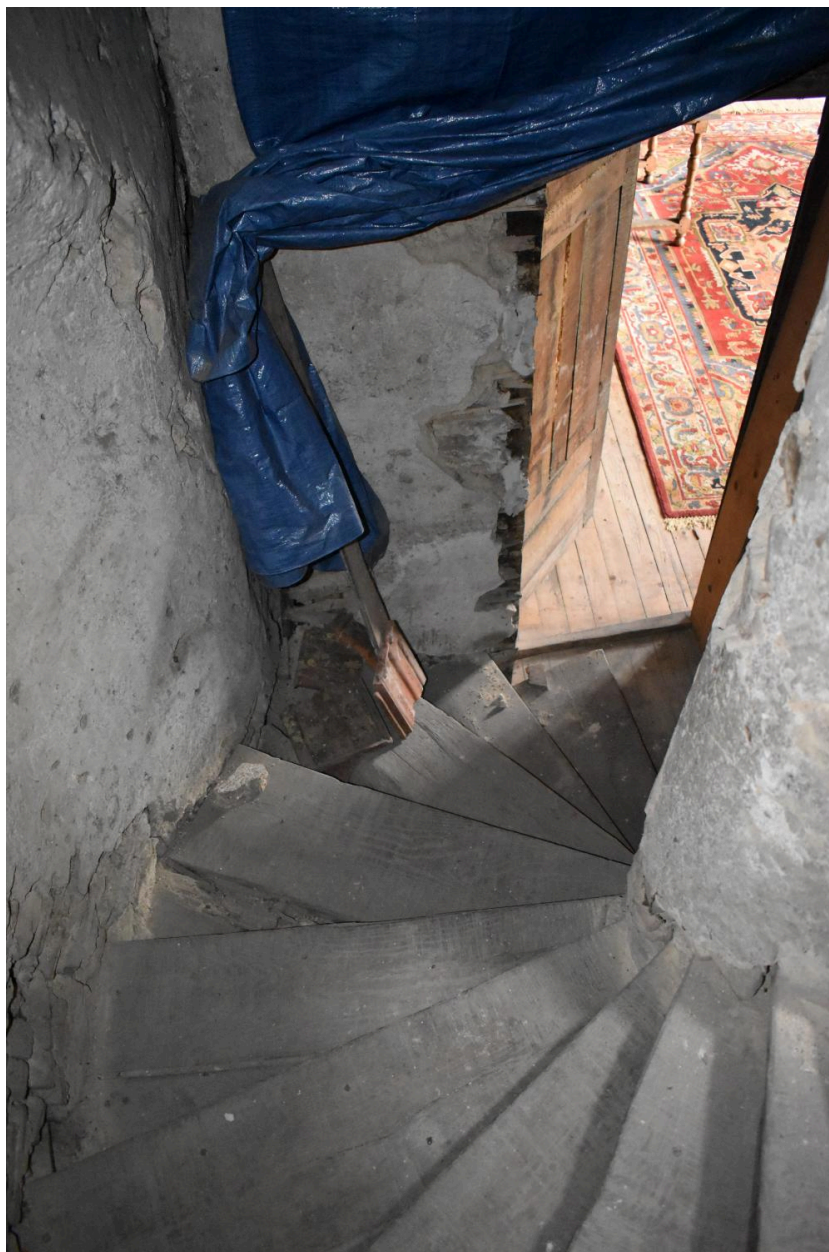
Escalier en vis conduisant à la chambre 3 de l'étage carré.
