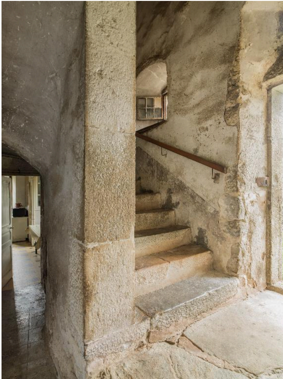
Vue intérieure de l'escalier : entrée, 1ère volée et couloir.
