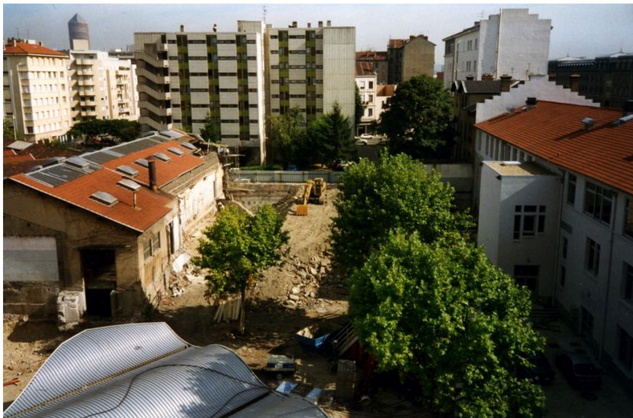
Vue des travaux dans la cour depuis le bâtiment A vers le nord, 1995
