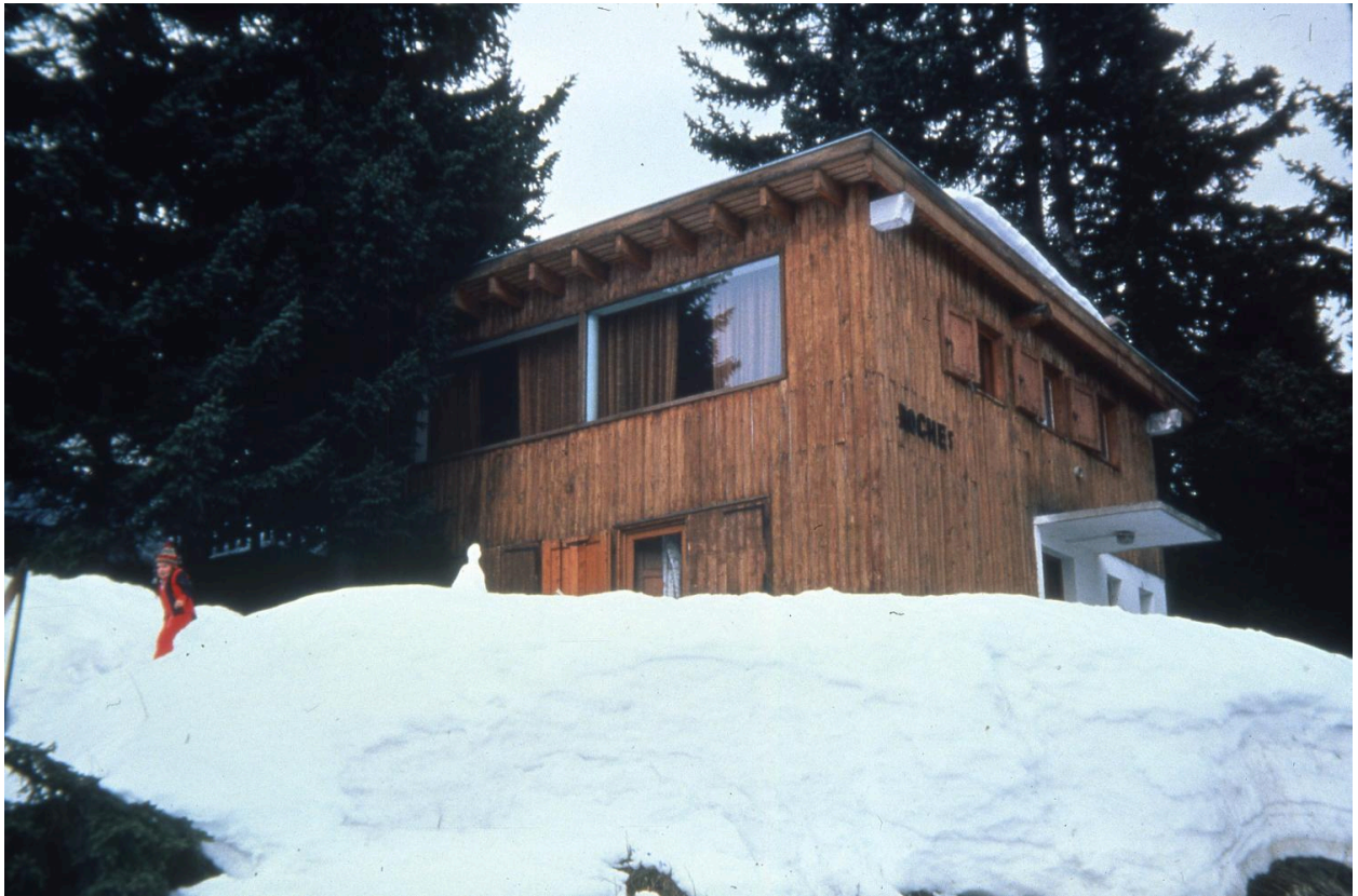
Vue de 3/4 droit avant les travaux de 1990
