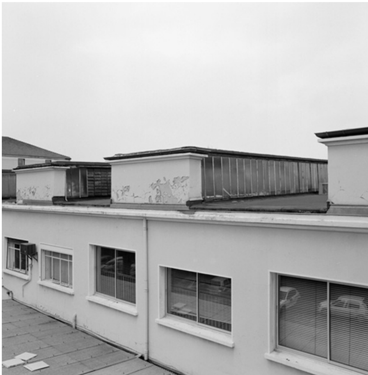
Détail toit, shed
