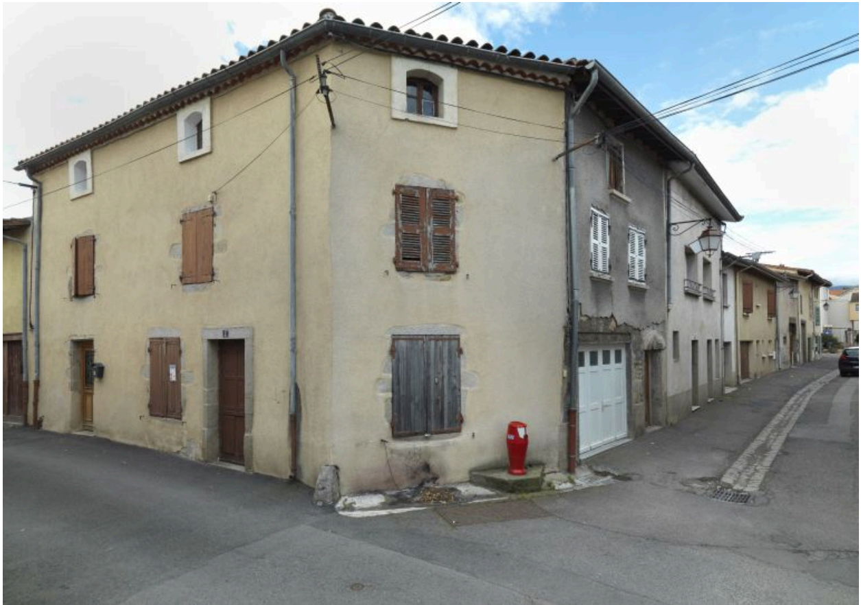
1986 AE 179, 180. 2 rue Georges Guynemer et 13 rue Centrale. Maison sur l'angle et maison avec porte au linteau avec écu, détail du linteau daté 1512.
