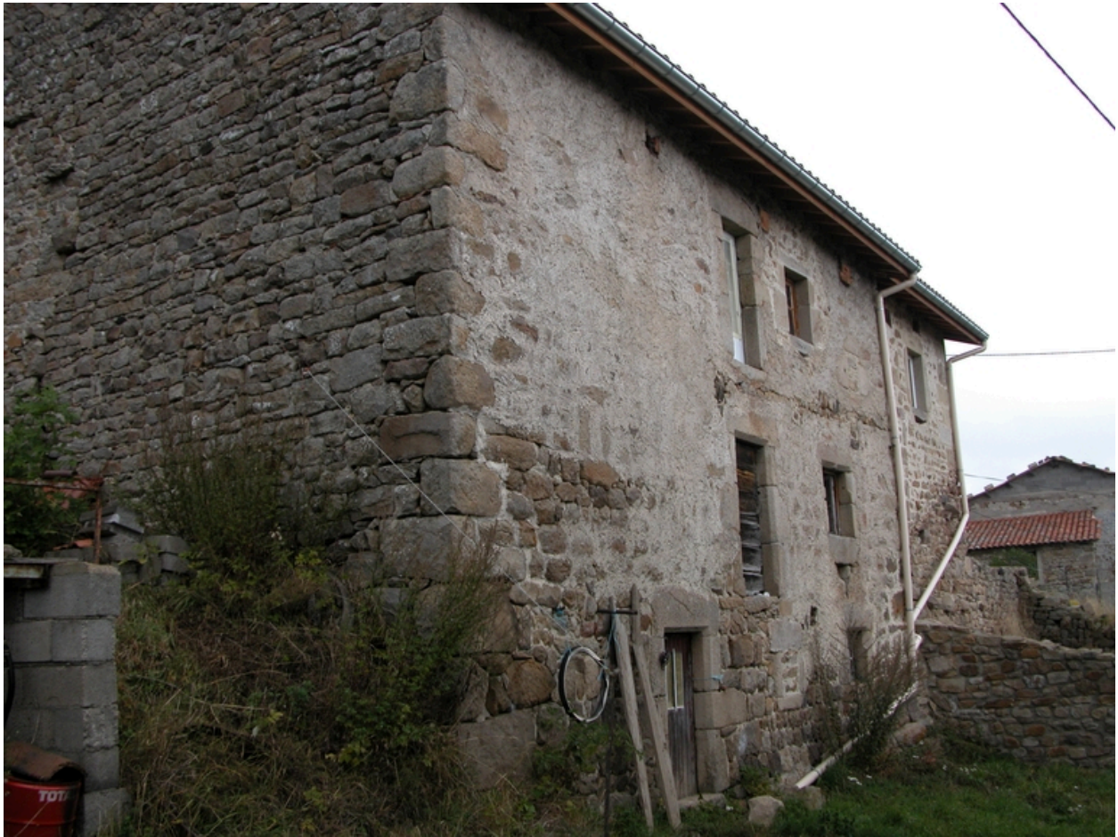
Vue d'ensemble de la façade sud du logis.
