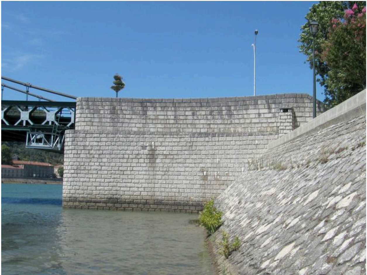
Culée de la rive gauche, face amont
